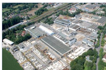
▲ Productie in Duitsland van prefab betonnen weegbrug modules
